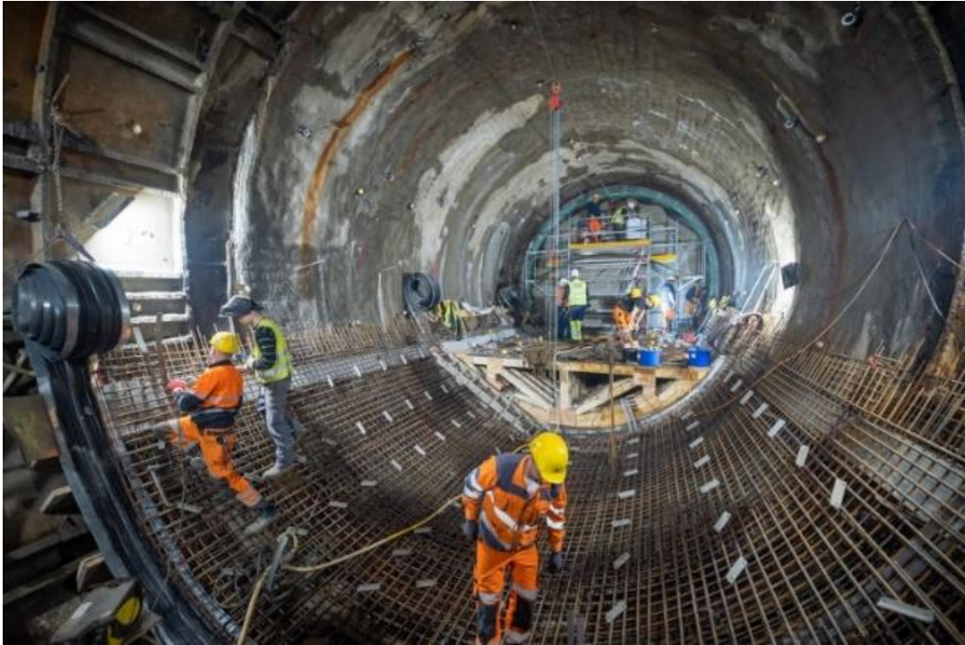
Bildunterschrift FOTO 1: Unter dem Platz der Republik mussten die letzten Meter Tunnel händisch hergestellt werden: Bewehrung und Schalung für die Betonage der Tunnelinnenschale werden eingebaut. Blick Richtung Bestandswand. © Klaus Helbig / SBEV GmbH
