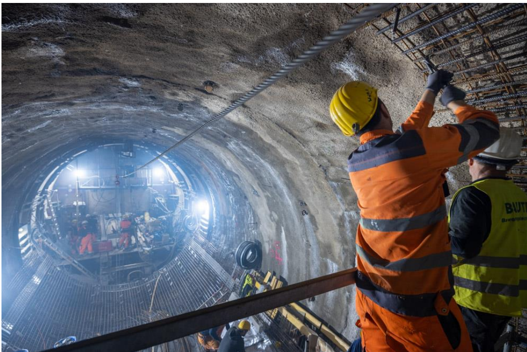
Bildunterschrift FOTO 2: Unter dem Platz der Republik wird die Bewehrung für die Tunnelinnenschale in die bereits hergestellte Tunnelaußenschale gebaut © Klaus Helbig / SBEV GmbH
