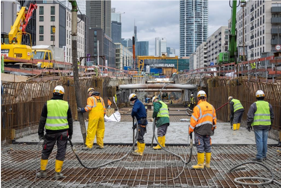
Betonage des Trogbauwerks für die Rampe, über die die U5 später an die Oberfläche gelangt. © Klaus Helbig / SBEV GmbH
